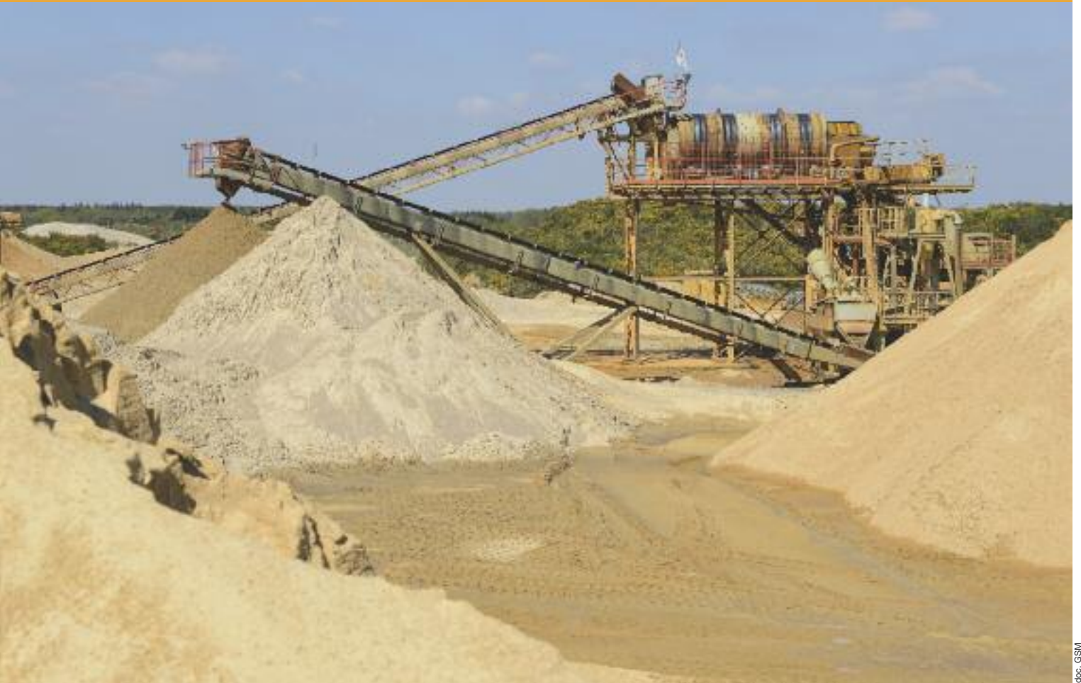
L'installation de traitement de la sablière de Missillac.
